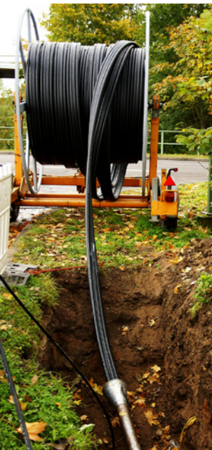
(Abb. 2) Tiefbau ist teuer: Deswegen ist eine Förderung des Glasfaserausbau gerade in ländlichen Regionen zwingend notwendig
